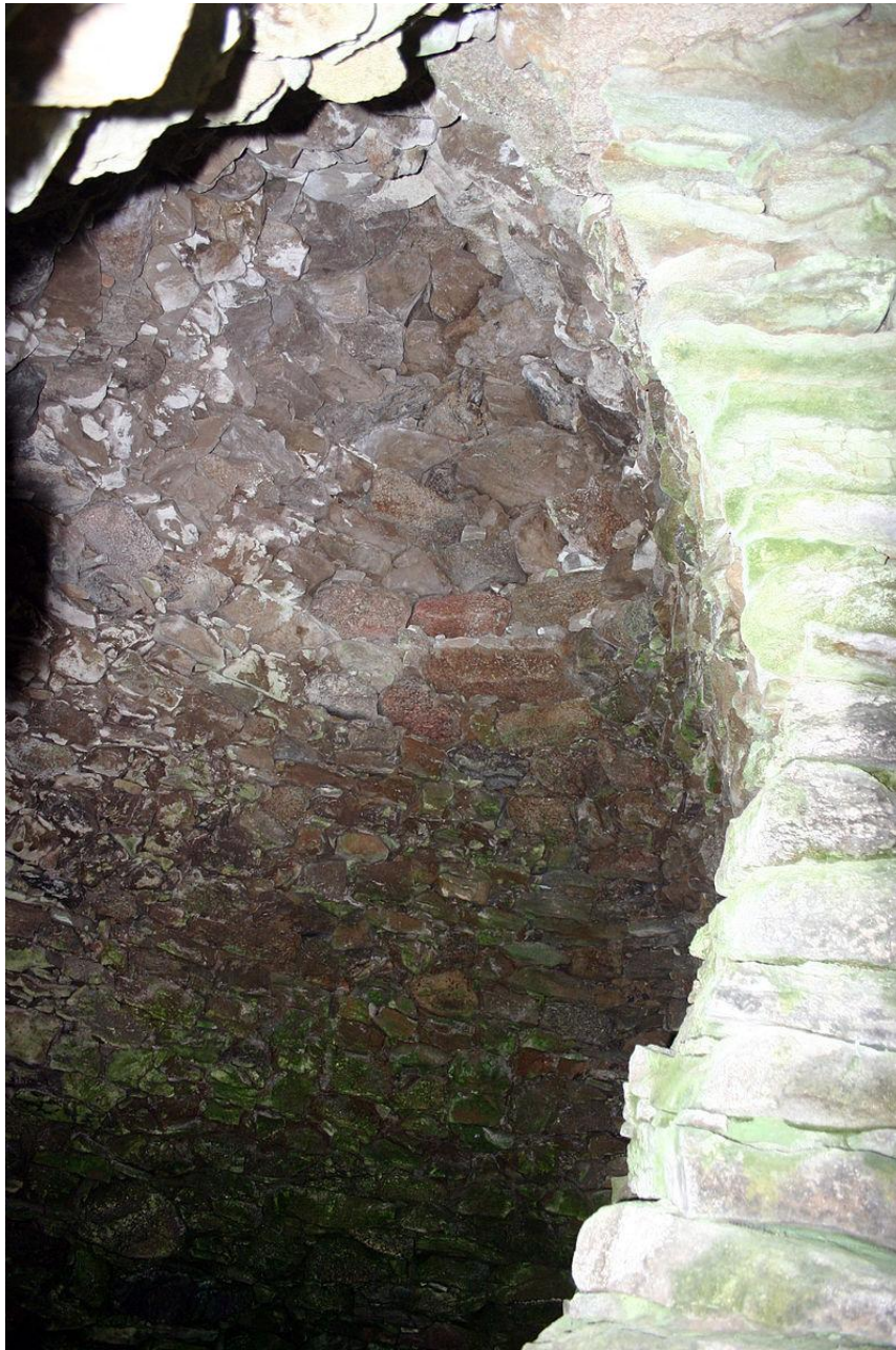
Vue en contre-plongée zénithale d'une voûte en encorbellement. À droite, un mur de soutien.
