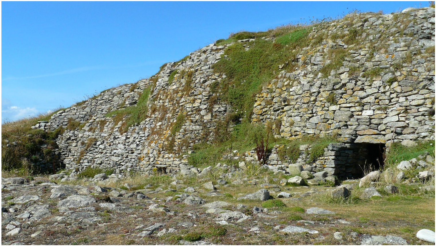
Parement frontal du cairn primaire, vu de l'est-nord-est. De droite à gauche, les entrées des dolmens nord, central et sud.
